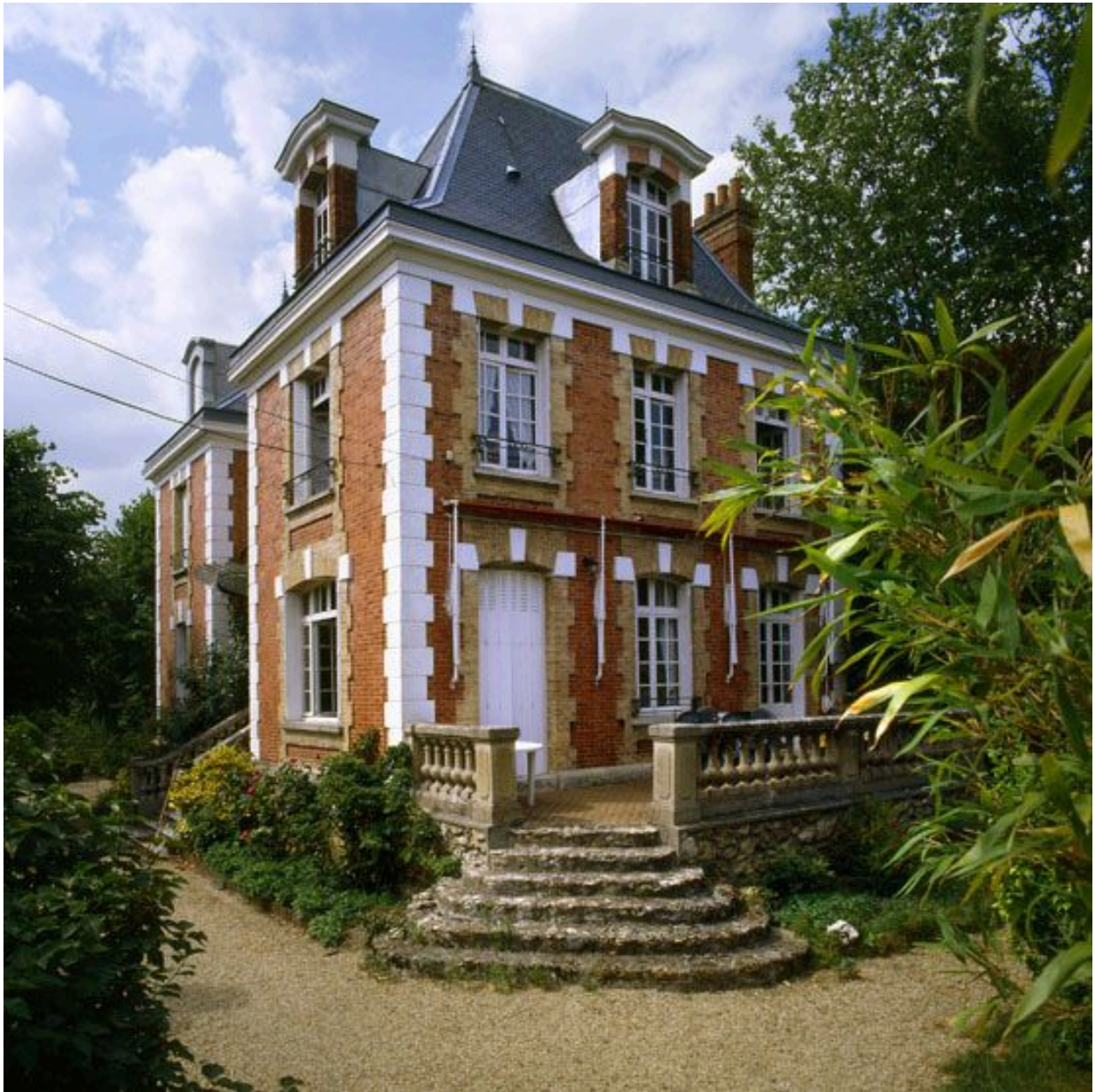
Façade antérieure et latérale. C'est cette dernière qui donne sur la Seine.
