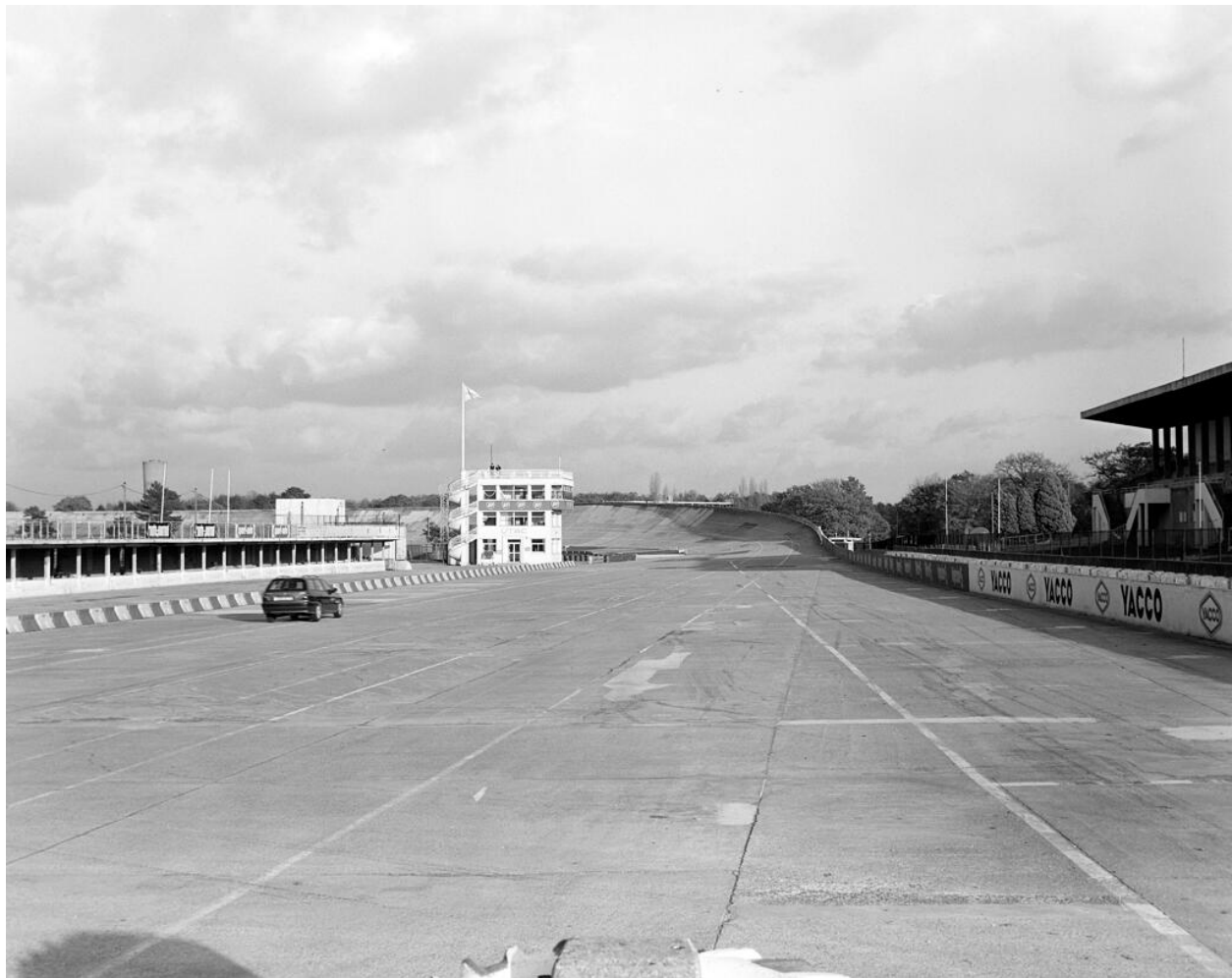
Vue de l'anneau de vitesse vers la tour de controle. Autodrome
