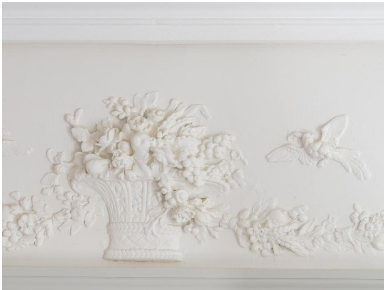
Détail de la moulure (mur de la pièce nord-ouest du rez-de-chaussée).
