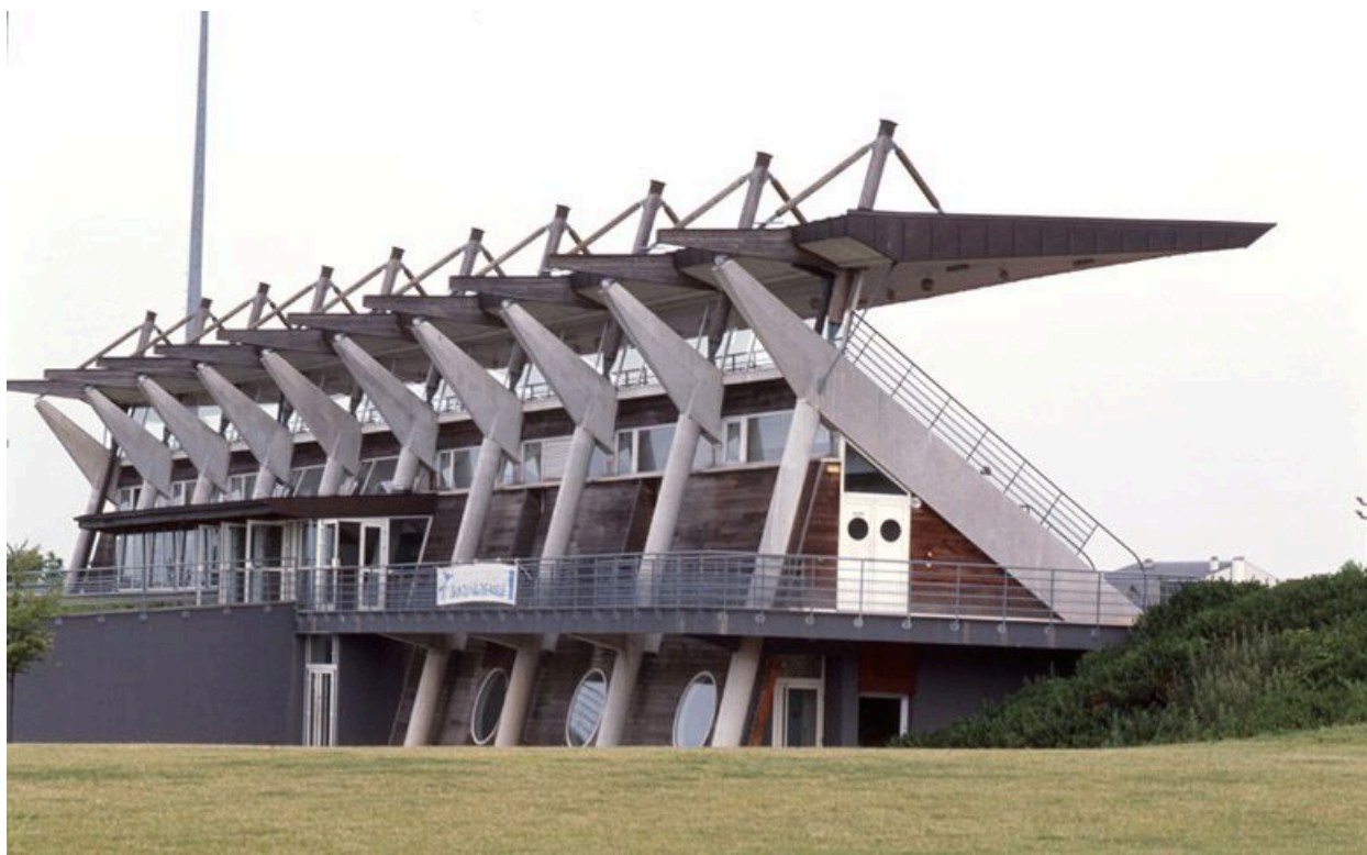
Stade des maisons rouges, 9 rue Clos Sainte Catherine. Vue rapprochée du bâtiment des tribunes. Lefebure, Gilles et Quertinmont, Jean-Louis (architectes).
