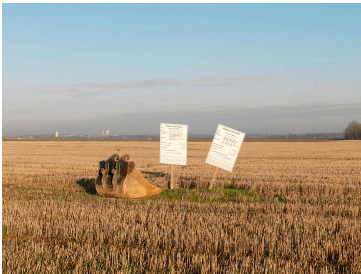
Saclay, la Martinière. Vue des champs lors des premiers terrassement du chantier du campus EDF.
