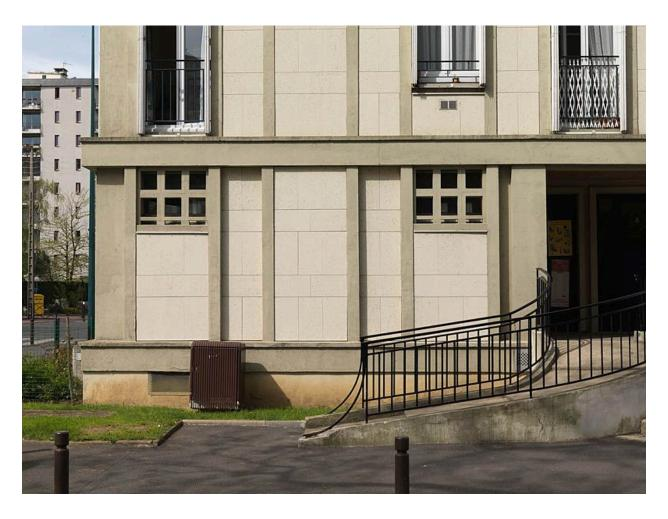
Façade avec une partie de la rampe d'accès. Les fenêtres du rez-de-chaussée ont été remplacées par de petites ouvertures avec un quadrillage de sécurité en béton.
