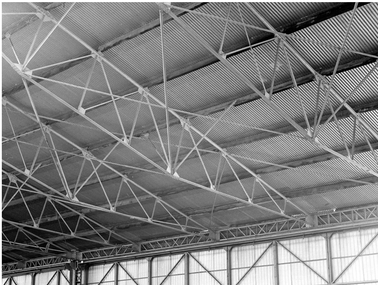
Détail des fermes métalliques.
