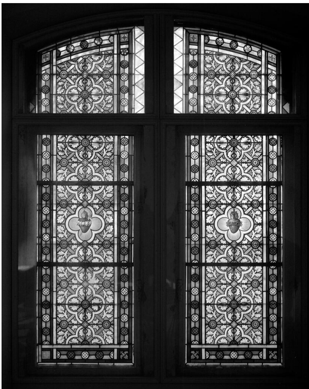
Verrière de la façade ouest
