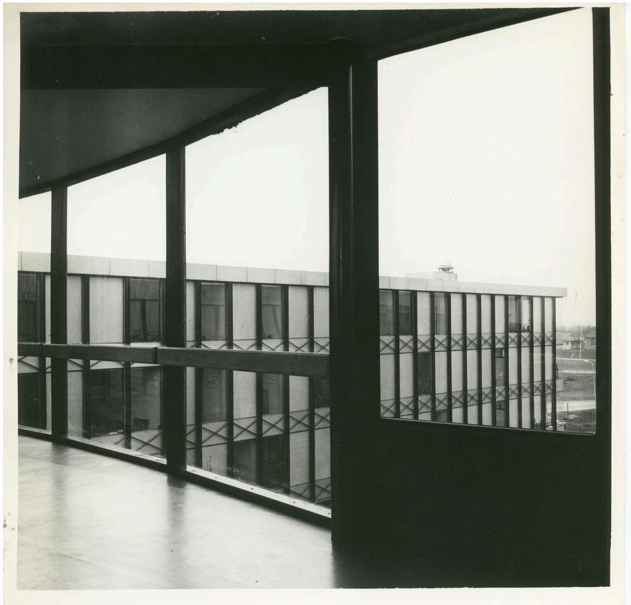
1961, le siège d'Air France ou bâtiment 363
