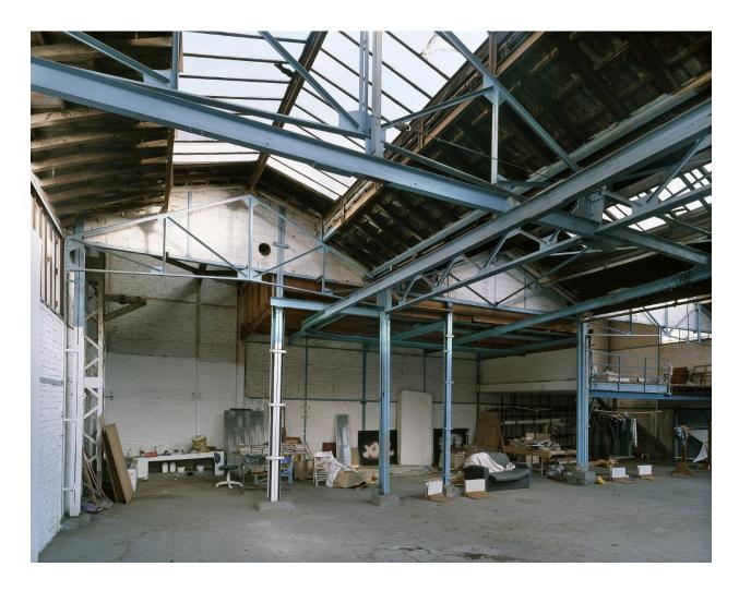
Intérieur de l'usine, depuis l'emplacement de l'atelier d'ébarbage. au fond à gauche, l'emplacement des fours ; au centre, l'aire de coulée surmontée du rail de soutien et de guidage des poches de métal en fusion ; au fond à droite, l'emplacement de l'établi des mouleurs et la grande étuve pour les moules.
