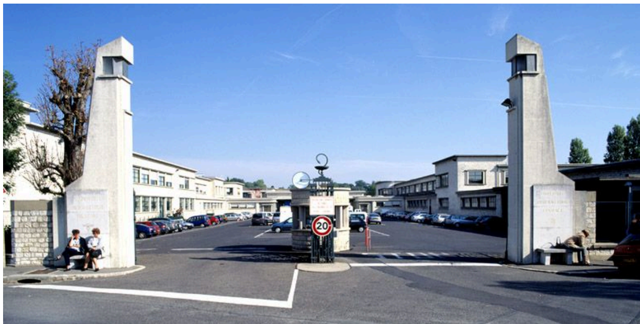
Portail sur la rue de la Motte-aux-Cailles : entrée de la cour centrale.
