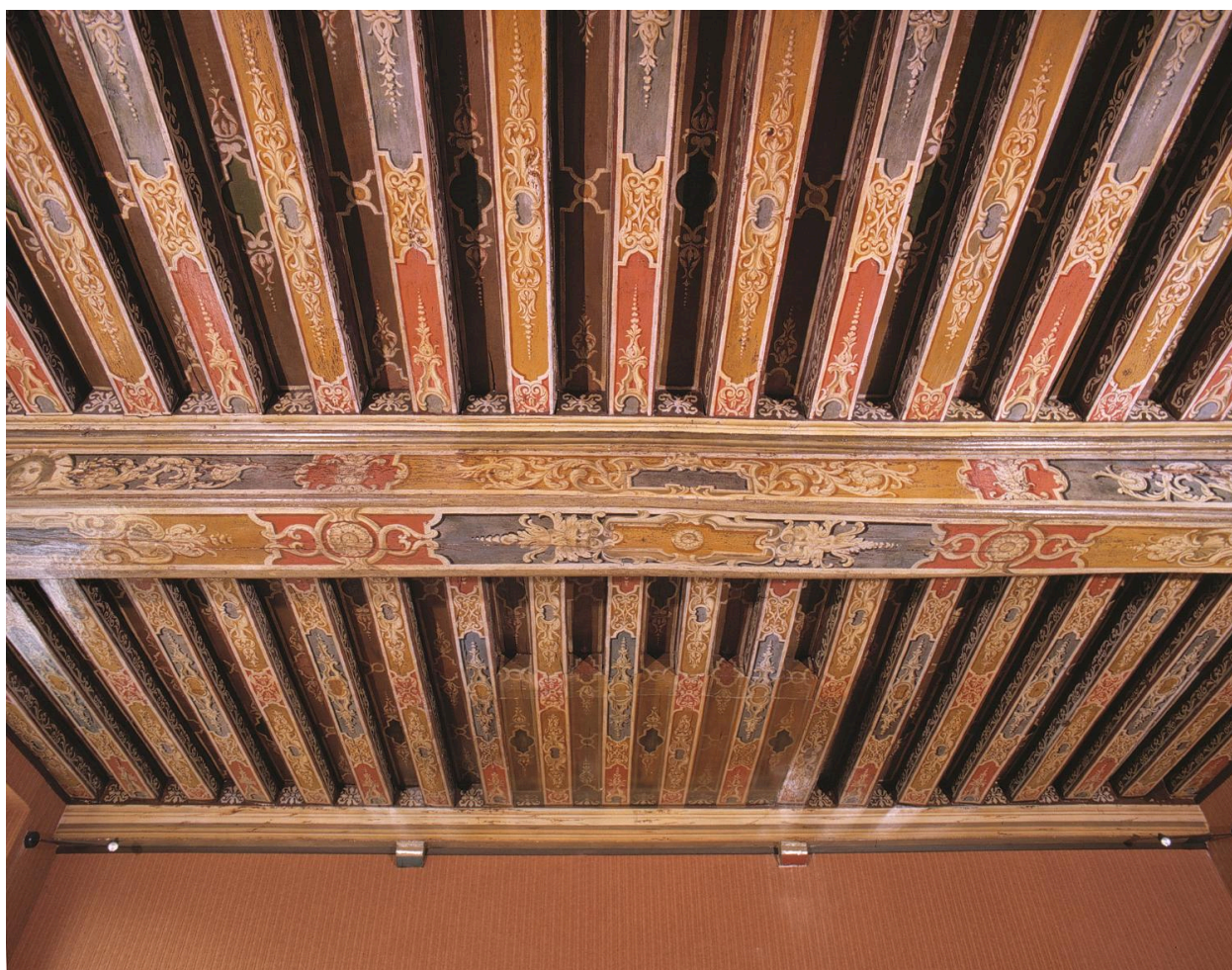
Vue d'ensemble du plafond à solives d'une des pièces du premier étage.
