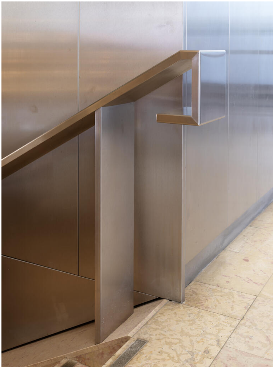
Détail de la rampe.
