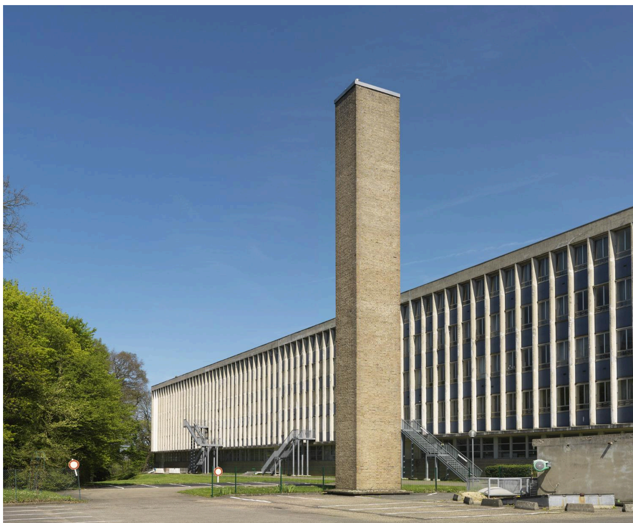
Vue générale de la façade ouest du lycée, avec la cheminée de la chaufferie au premier plan.
