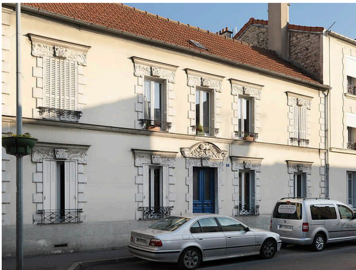
Alfortville, maison, 47 rue Véron. Vue d'ensemble.
