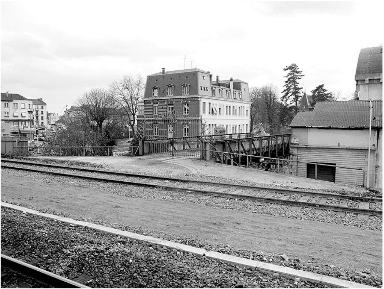
Bâtiment des bureaux : vue d'ensemble, depuis la voie ferrée (élévations nord et ouest). Photographie avant destruction, 1989. (Ministère de la culture, Inventaire général. 89SG684X)
