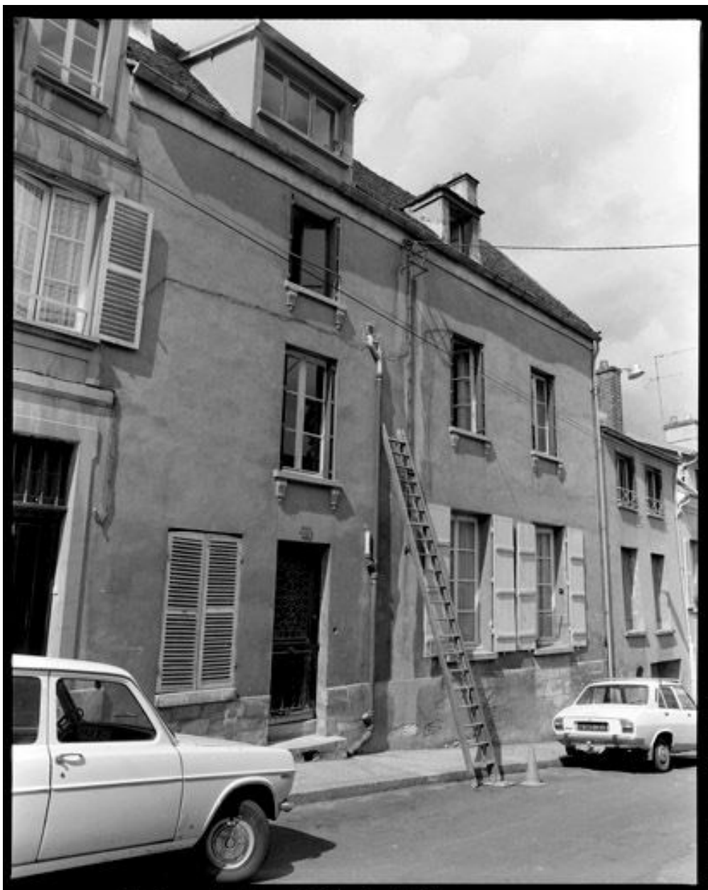
Maison, Gâte-Vigne (rue) 4. Vue de la façade sur rue.
