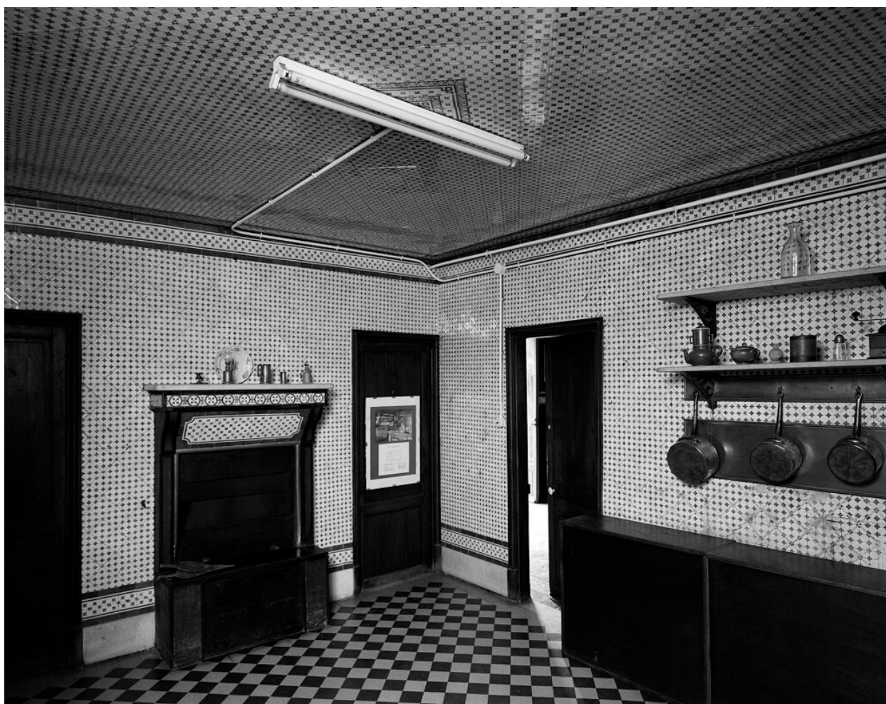
Tour Nana : la cuisine au rez-de-chaussée
