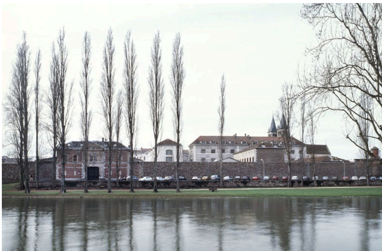
Vue générale, depuis le nord.
