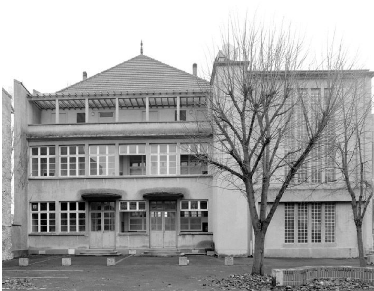
Façade sur cour de l'extension des années 1950.
