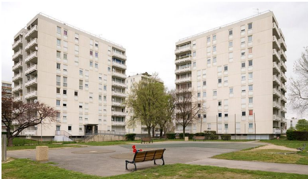
Alfortville, cité dite grand ensemble nord d'Alfortville. Vue des bâtiments de l'allée Jean-Baptiste Lulli.
