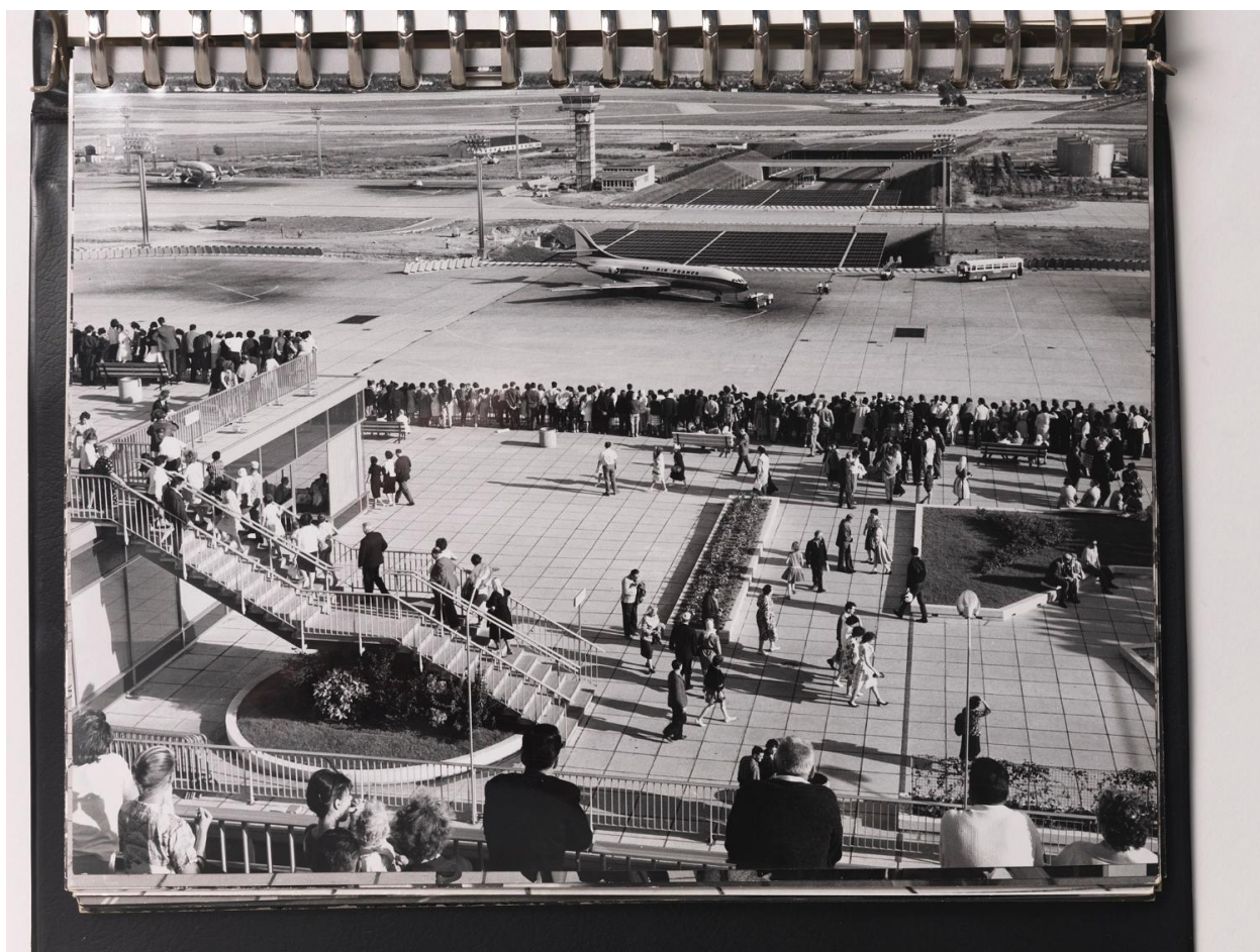
Les terrasses, 4ème étage, "Orly Installations Terminales", album de photographies destinées à la presse édité par l'Aéroport de Paris, 1961.
