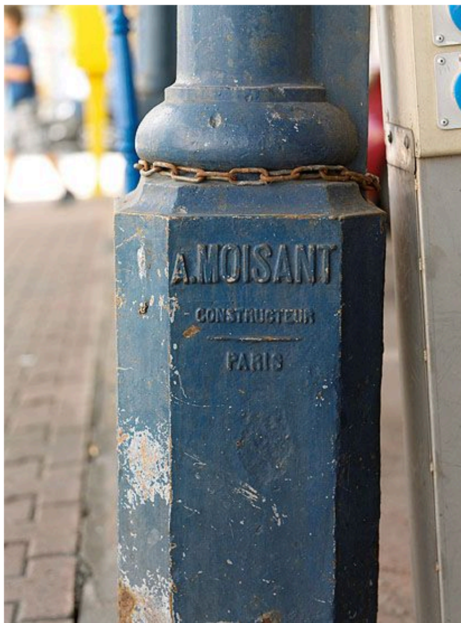
Détail de la signature "A. Moisant. Constructeur. Paris".
