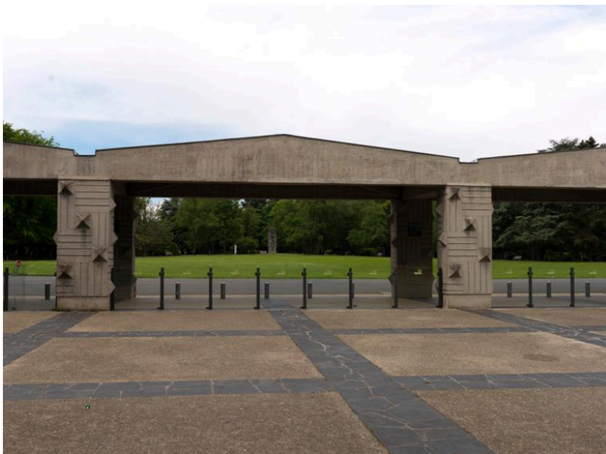
Le monument de Calca dans la perspective de l'accès piéton.
