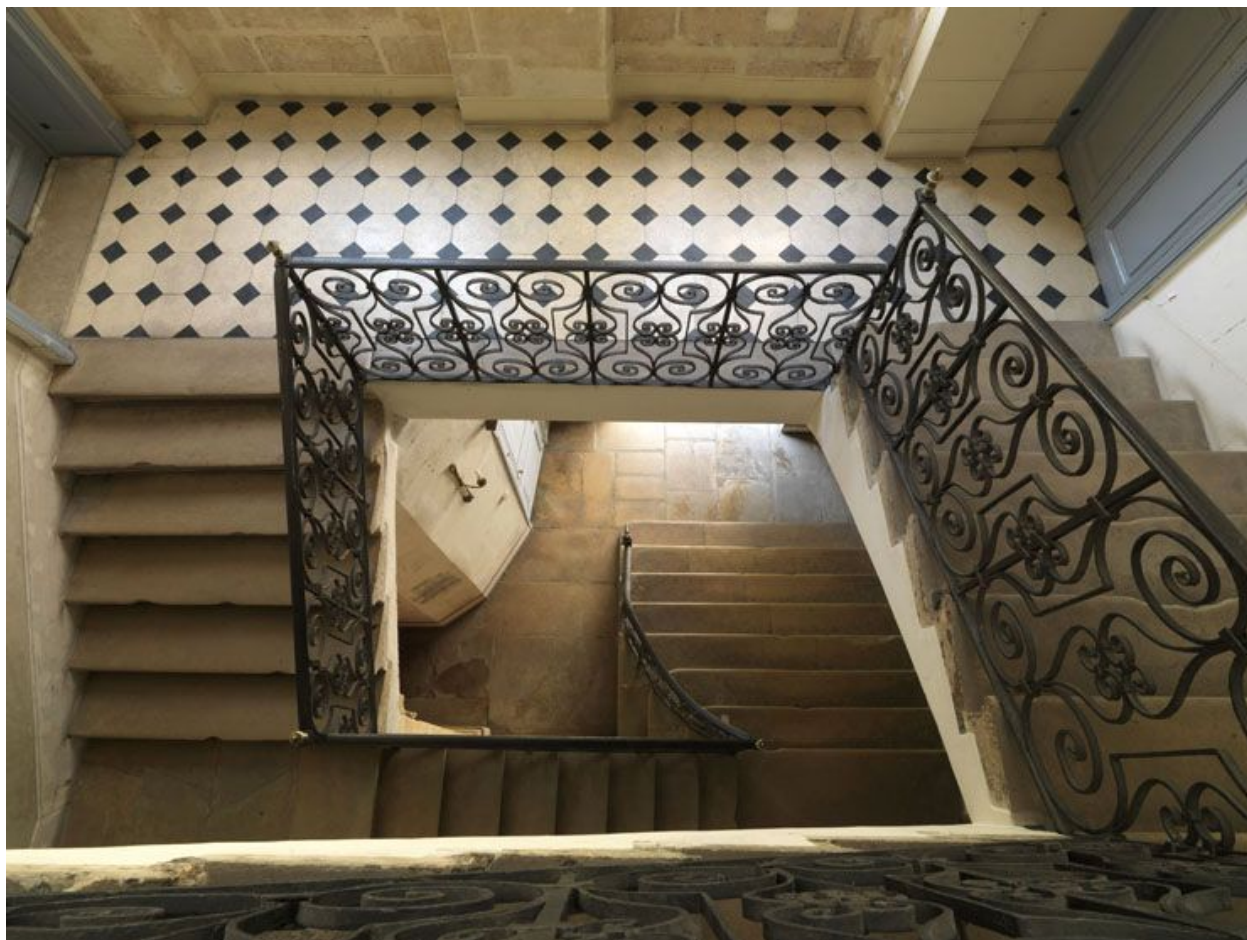
Vue en plongée du vide de l'escalier.
