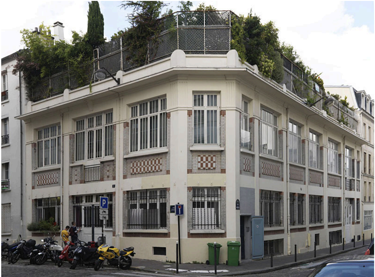
Petit immeuble d'ateliers implanté à l'angle de la rue des artistes et de la rue Gauguet.
