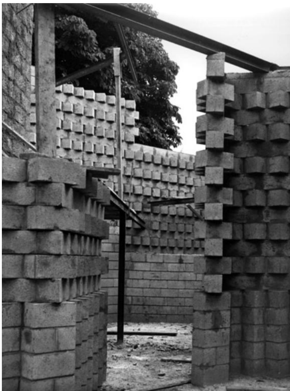
Vue ancienne du chantier de construction.
