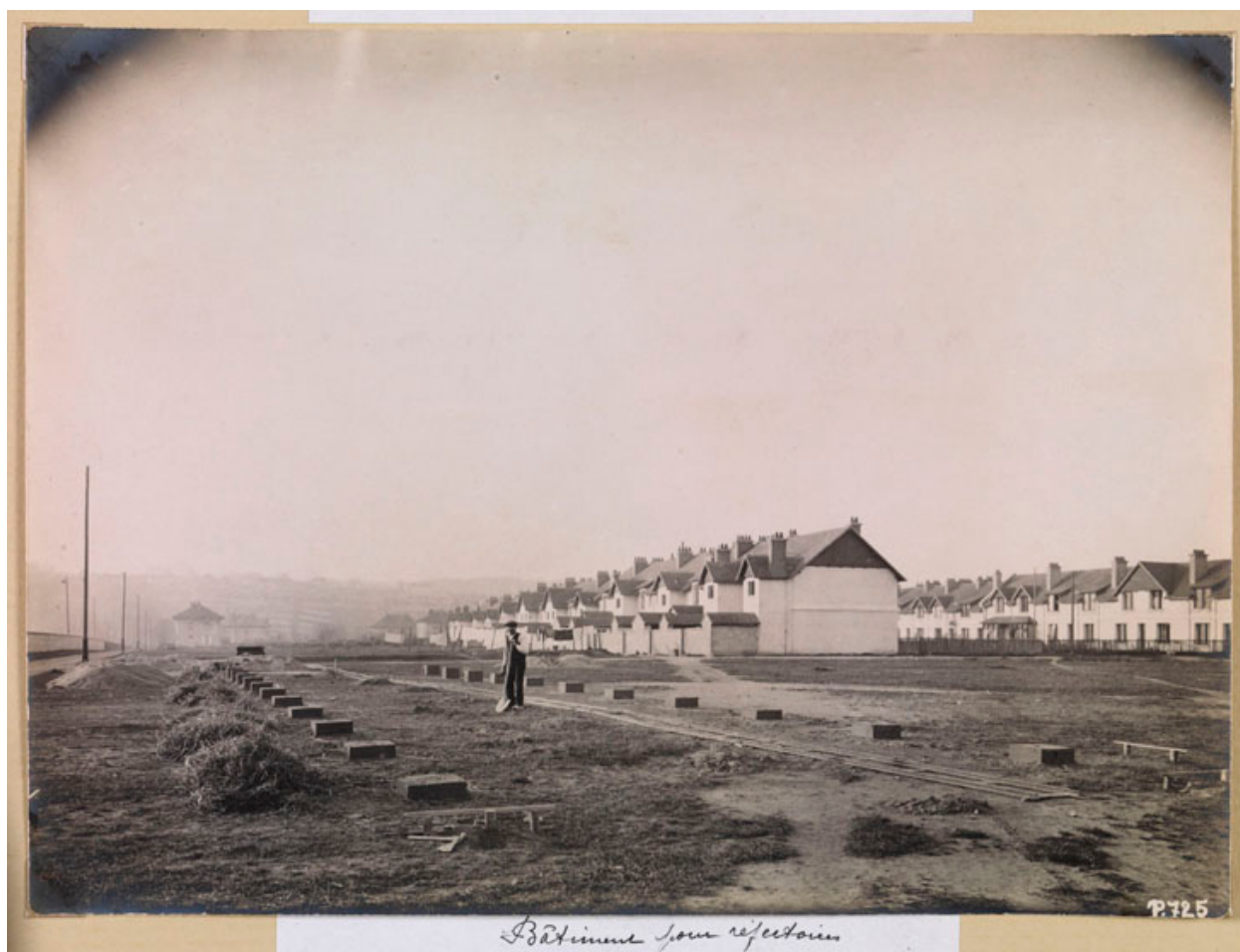
Photo ancienne de la construction du lotissement.
