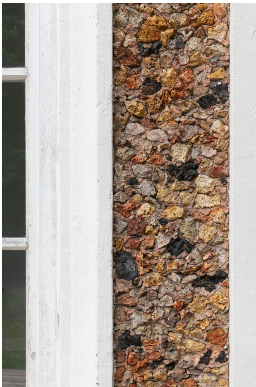
Détail du rocaillage de l'orangerie.
