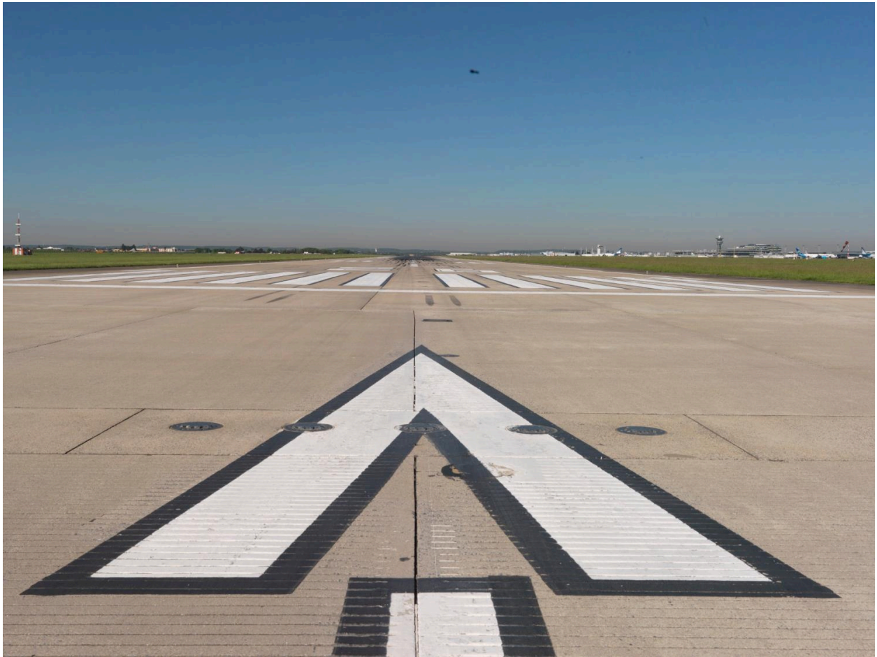
2018, marquages au sol du seuil de la piste n°3 vus depuis le nord-est.
