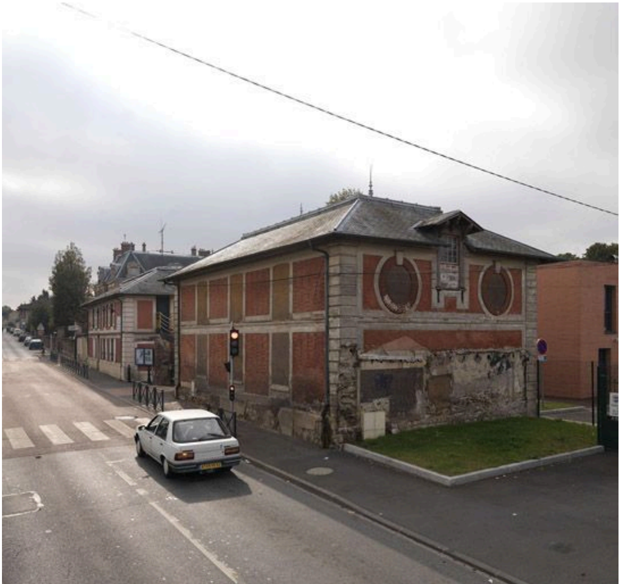
Vue des anciens communs, 40, rue Pierre-Marin.
