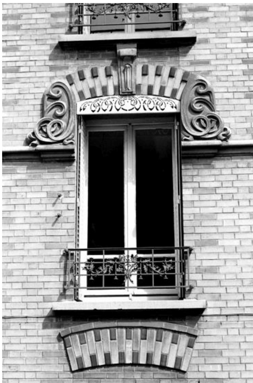
Fenêtre au premier étage.
