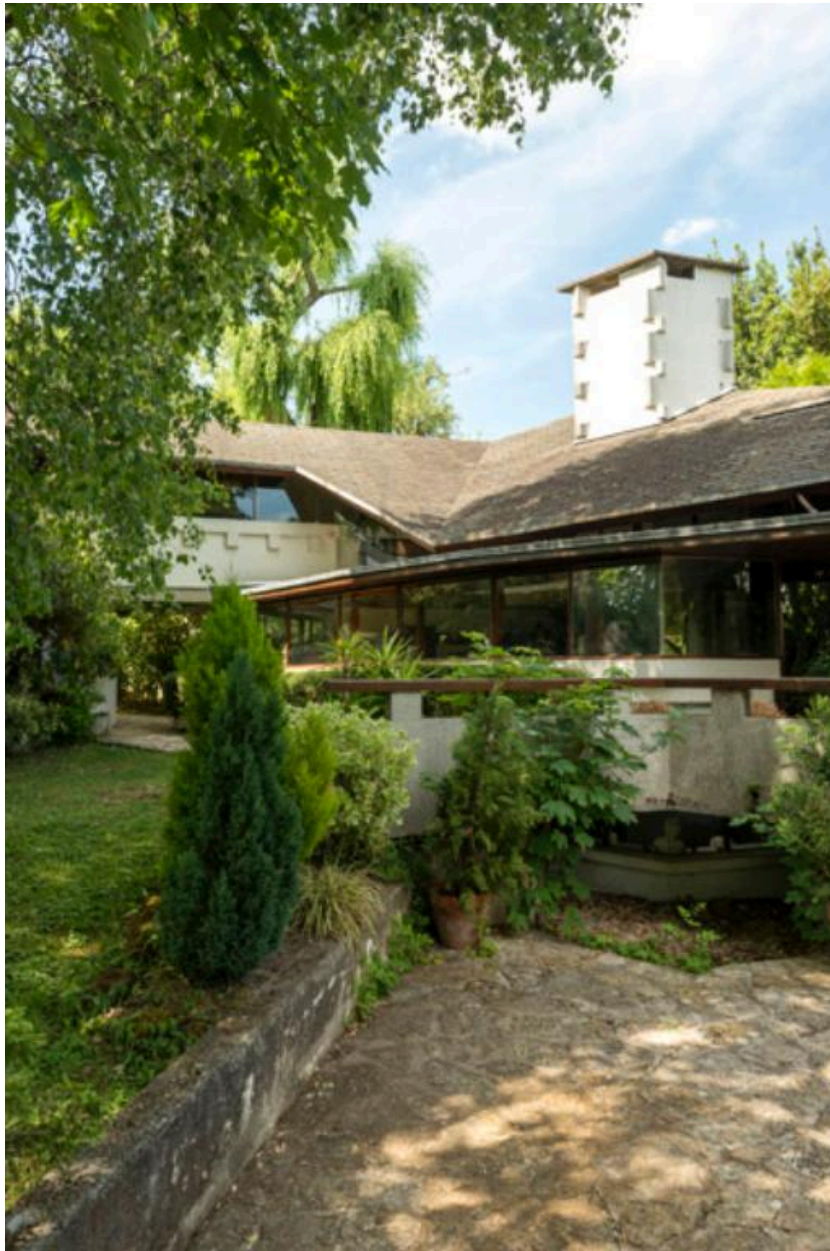
Vue générale de la cheminée et de la toiture de l'aile principale.
