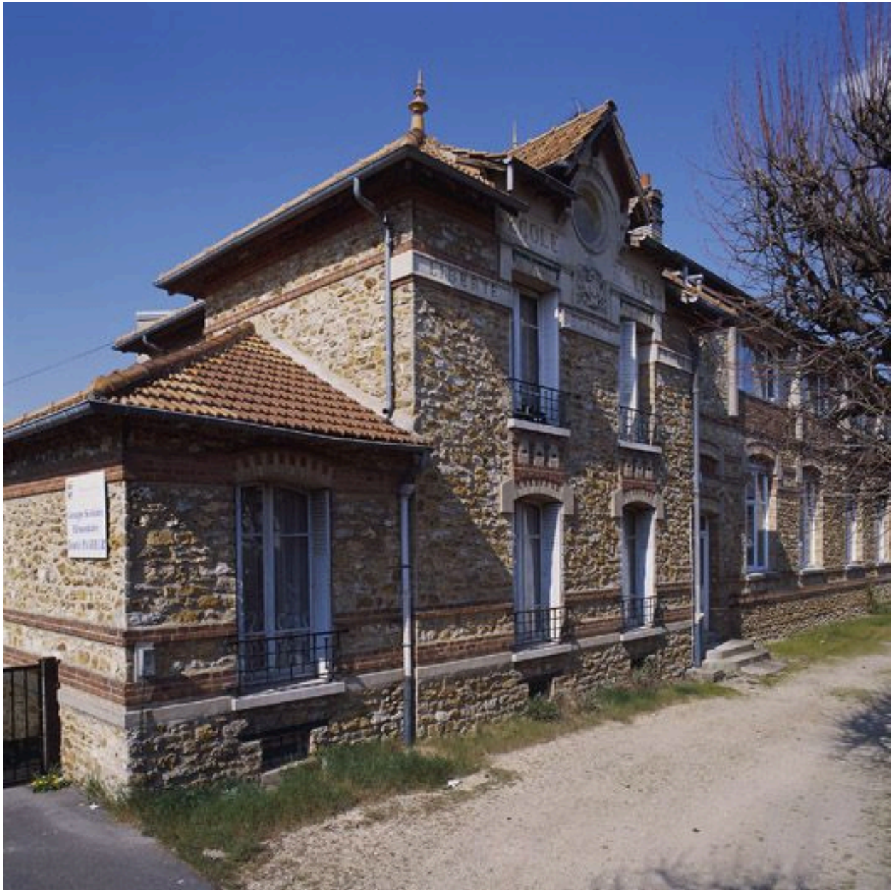
Pavillons ouest et premières travées du groupe scolaire correspondant à l'école de filles construite en 1906.
