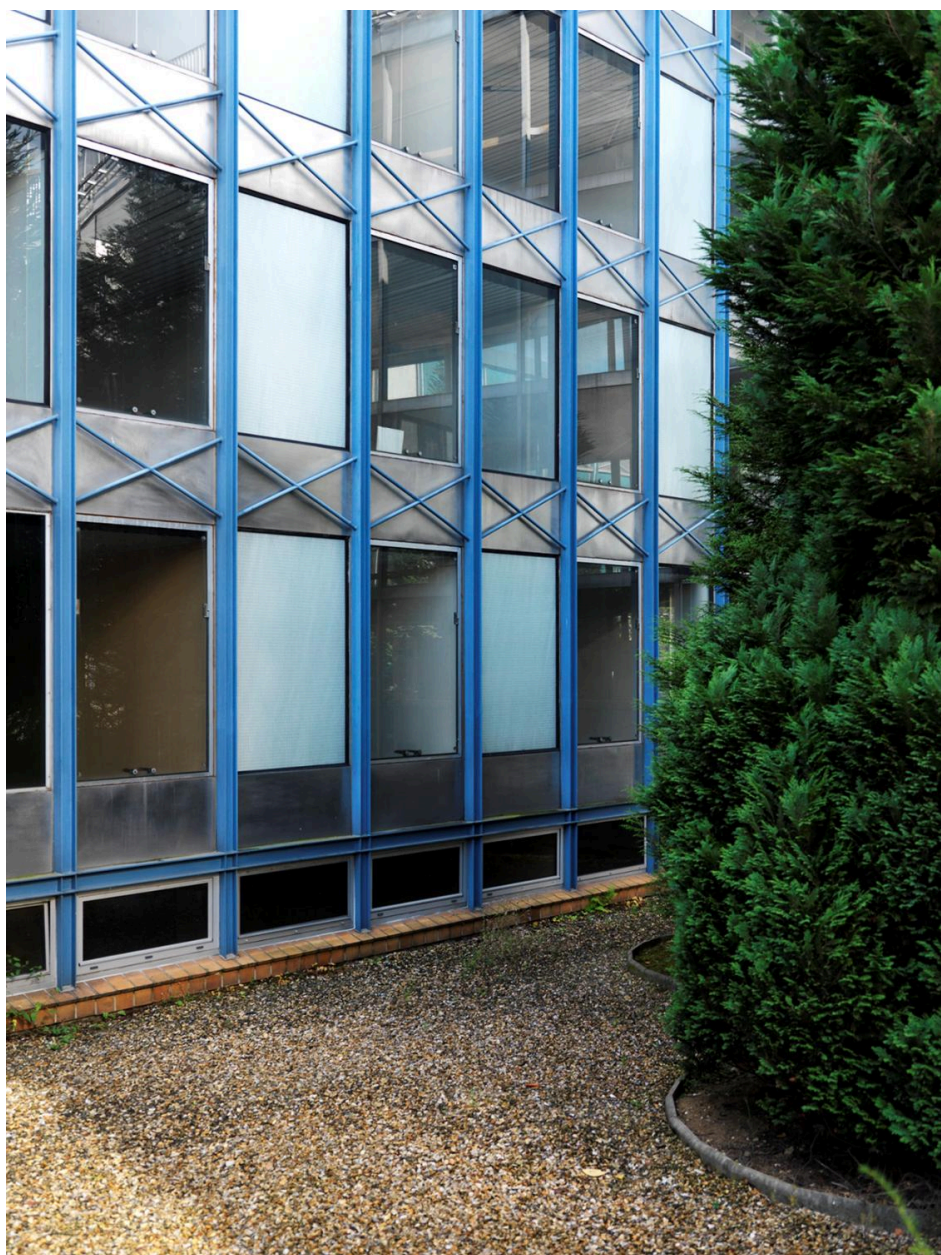
2012, le siège d'Air France ou bâtiment 363, détail de la façade.
