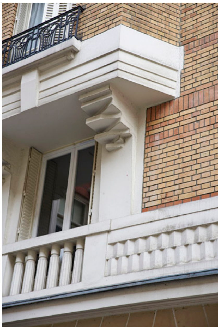
Vue de l'encorbellement d'un bow window.
