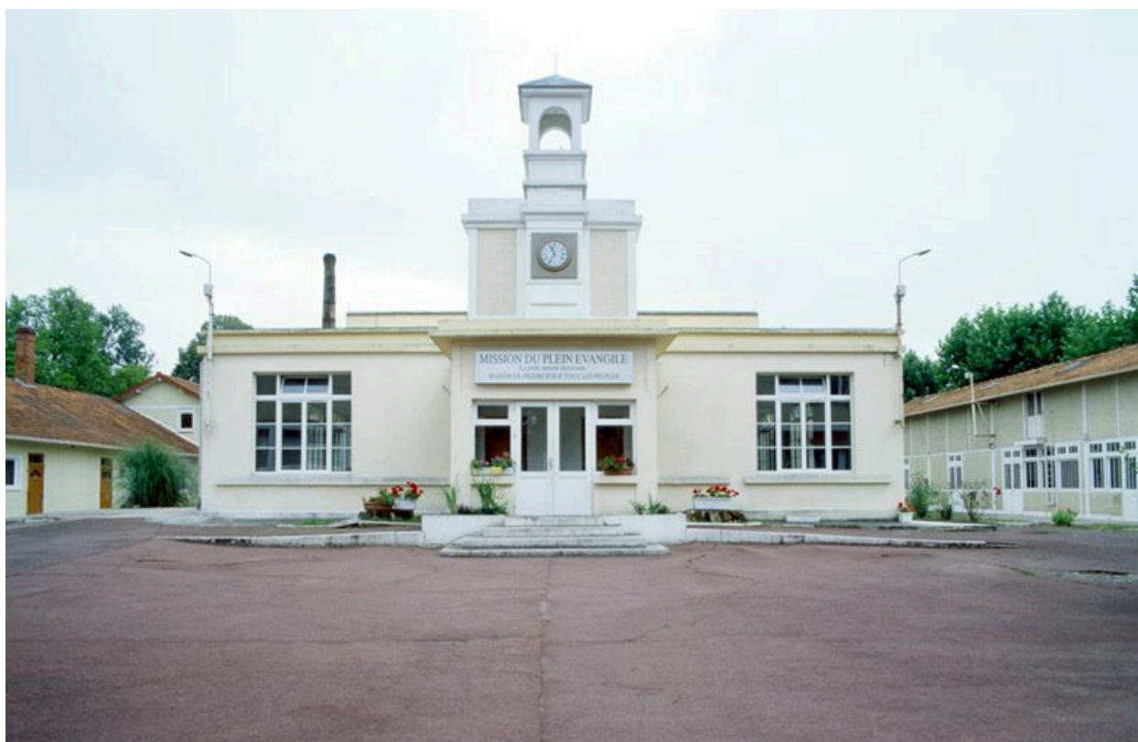
Vue du bâtiment administratif au centre de la cour.
