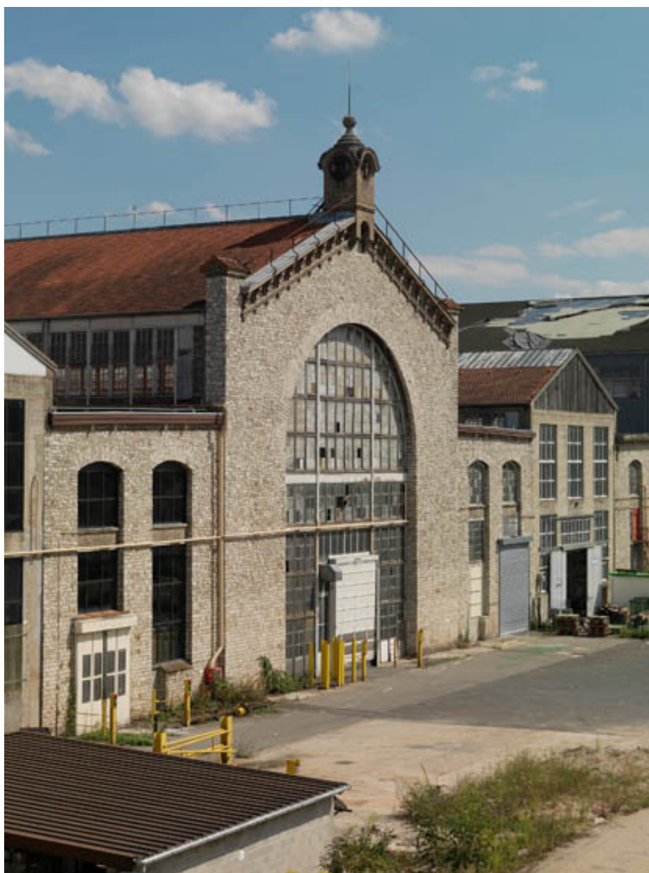
Vue extérieure de la nef centrale côté Seine.
