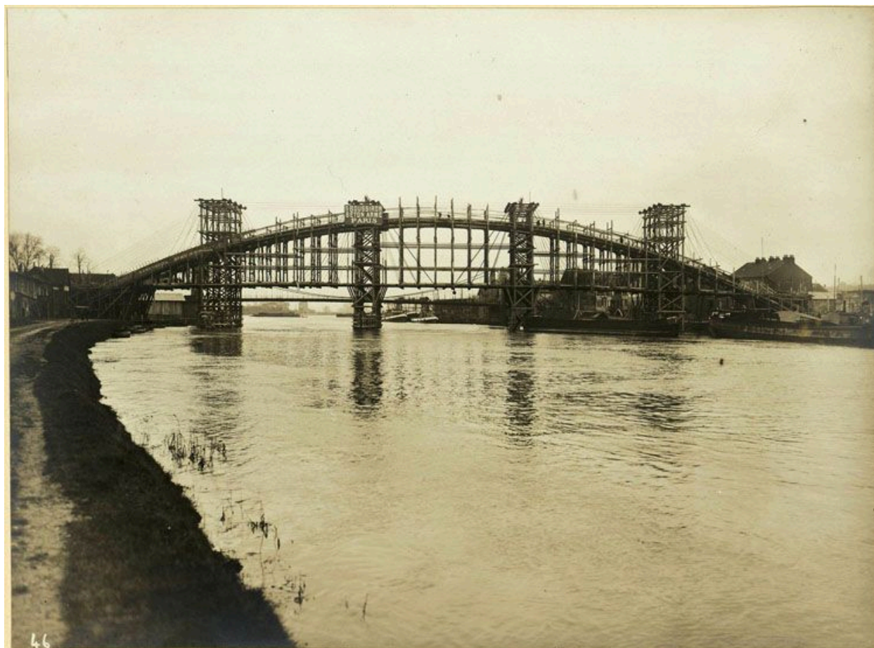
La reconstruction du pont sur l'Oise en 1927. Photographie. (AD Yvelines, 2F 108/37).
