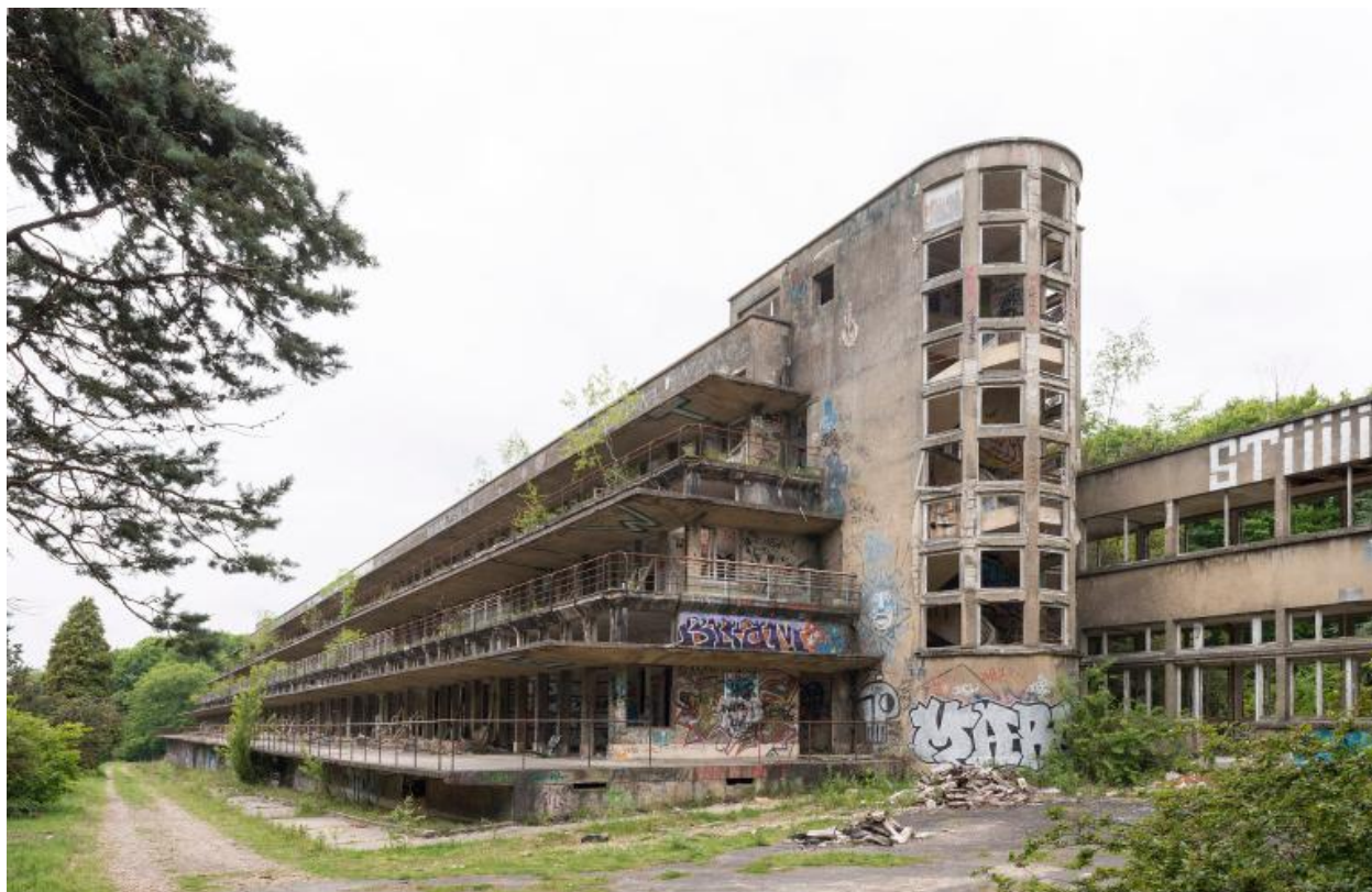
pavillon Bonnefoy-Sibour, façade sud (1)
