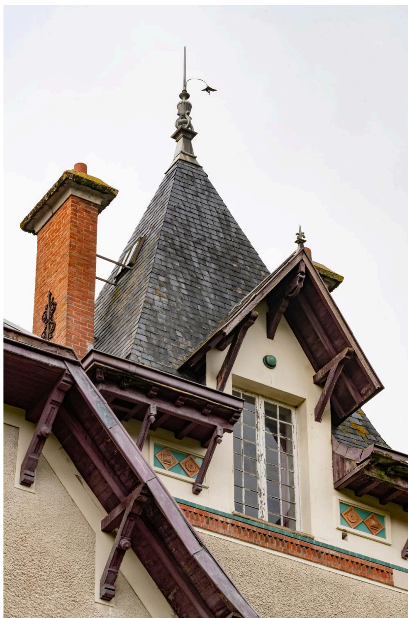
Lucarne de la tour d'escalier
