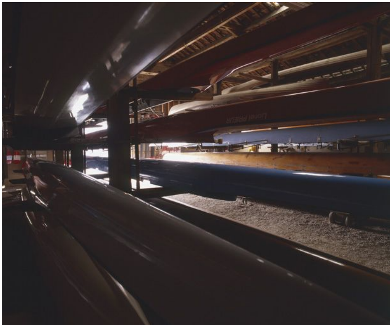
Vue à contre-jour d'une travée intérieure du second hangar à bateaux.
