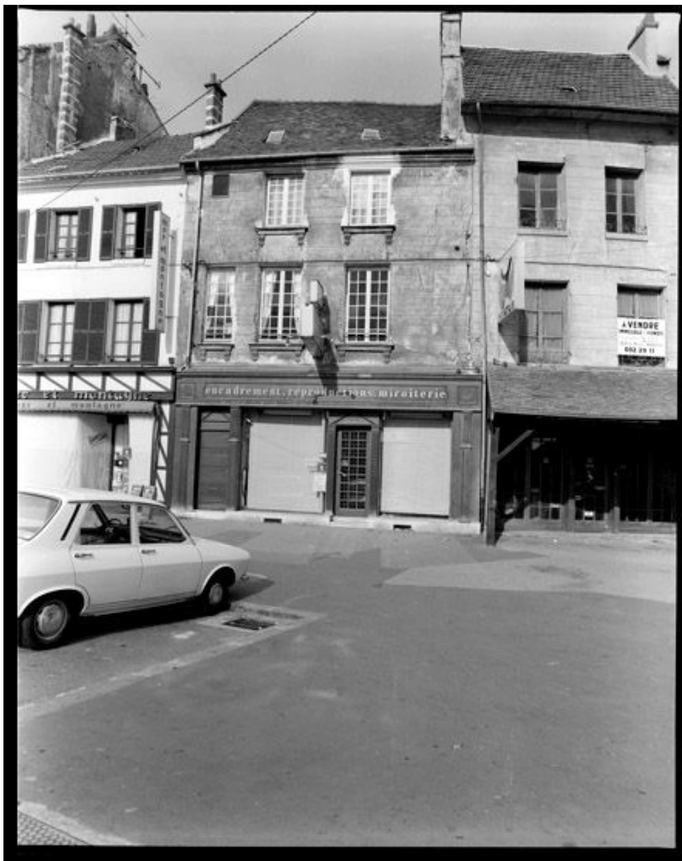
Maison, Thiers (rue) 28. Vue de la façade sur rue.
