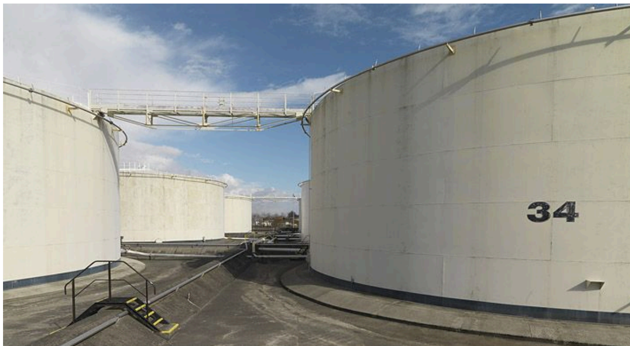
Villeneuve-le-Roi, dépôt pétrolier. Vue de réservoirs.
