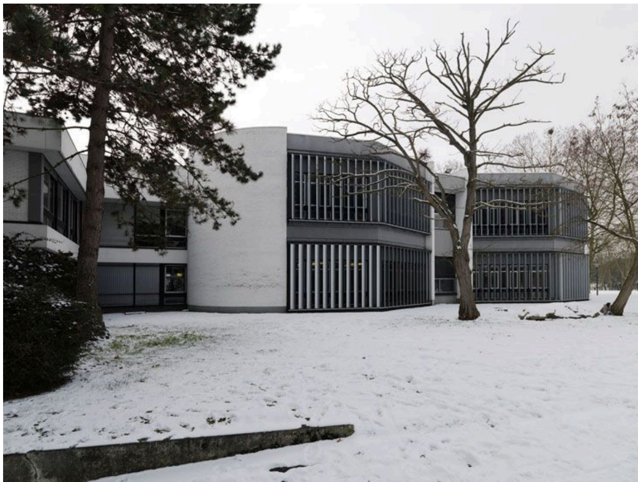
Vue des façades donnant sur le parc de la Préfecture.
