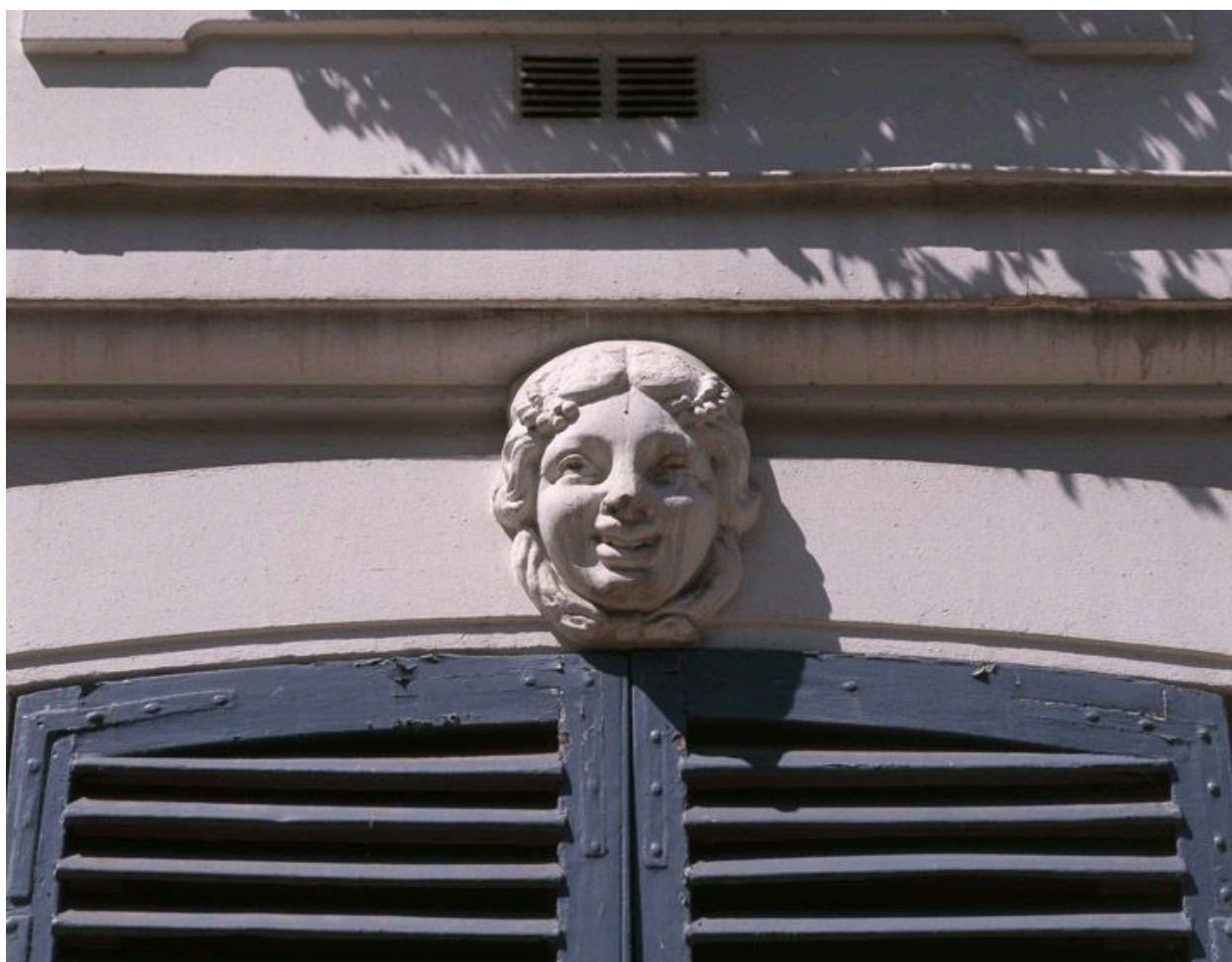
Détail d'un mascaron en agrafe au-dessus d'une baie du rez-de-chaussée (tête de femme).
