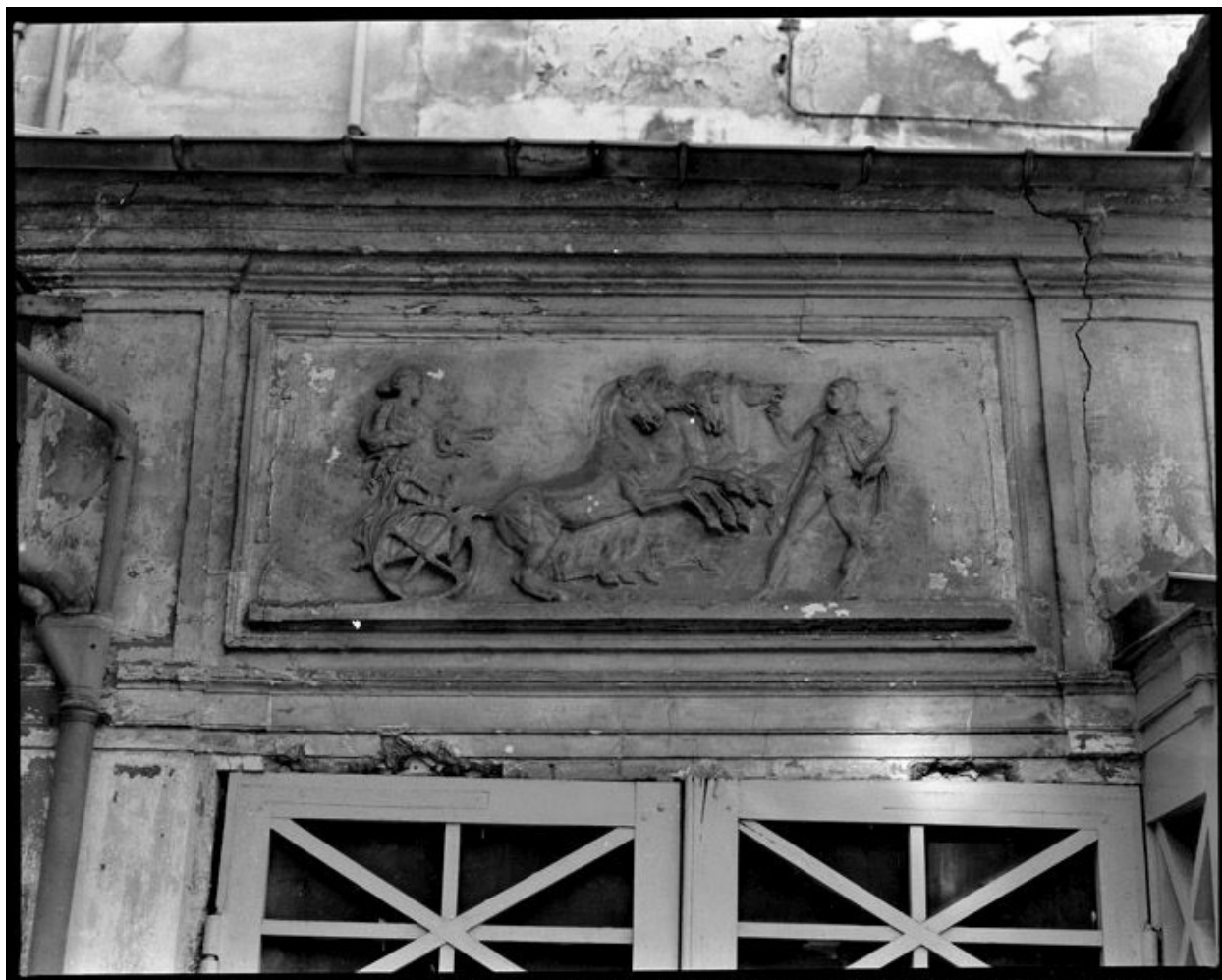
Maison, Gambetta (rue) 2. Décor des anciennes écuries.
