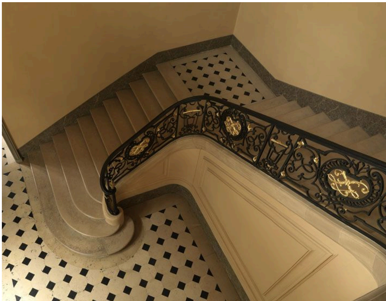
Vue en plongée des premières volées.
