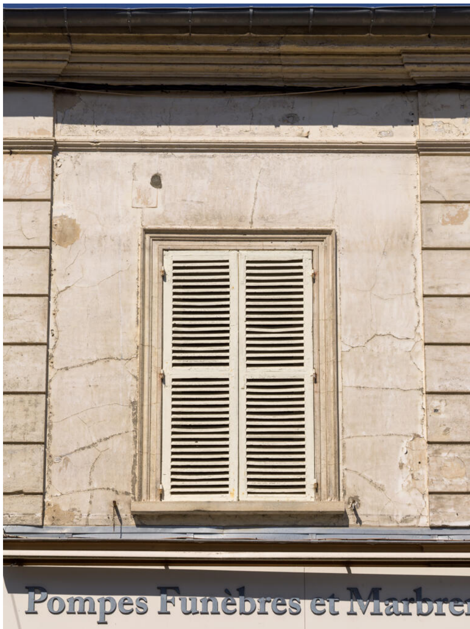
Détail d'une baie de l'étage.
