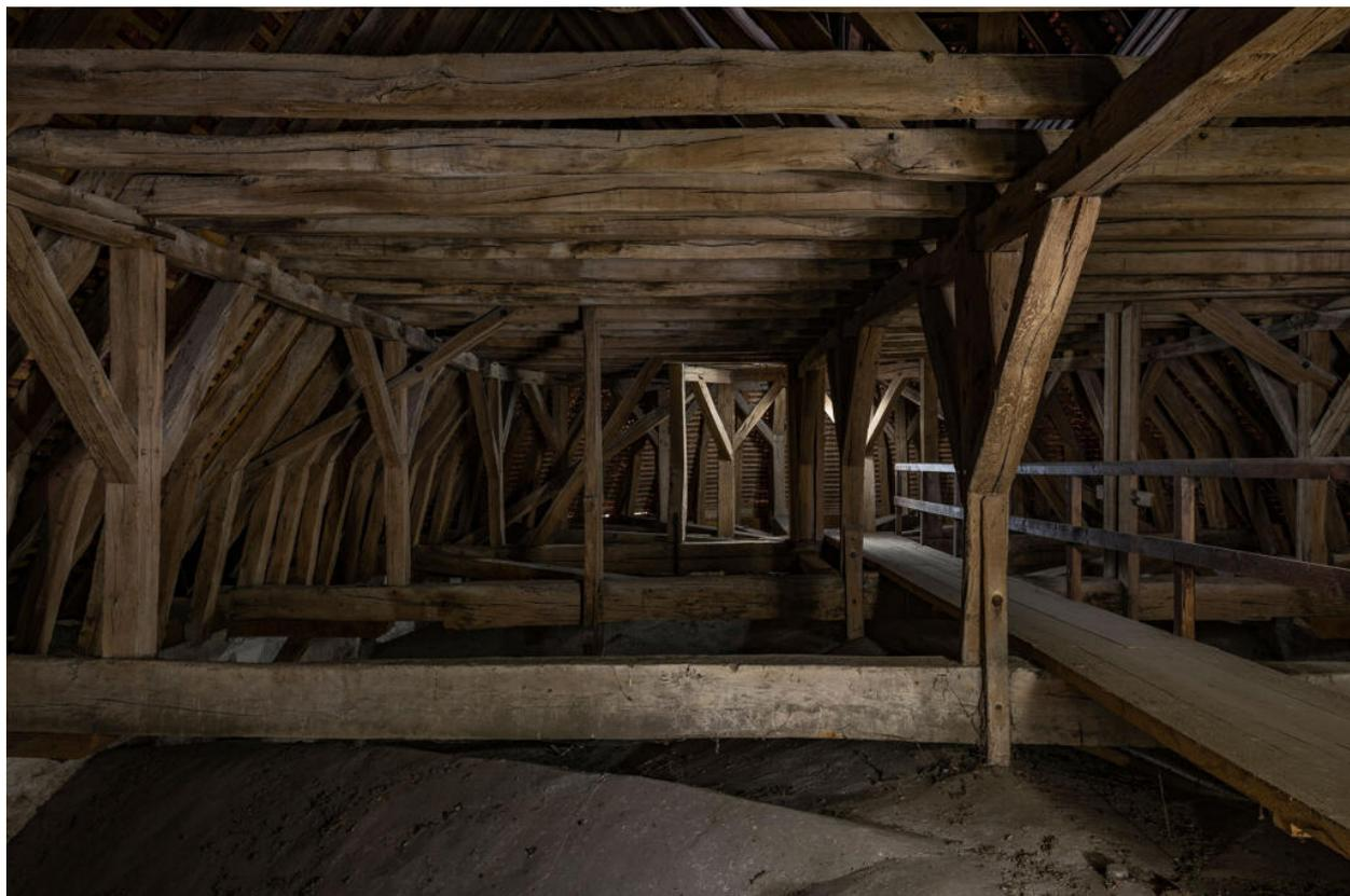
Vue de la charpente quelques travées avant le chevet. On distingue bien l'entrait juste au dessus de l'extrados des voûtes.
